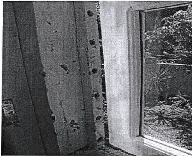
Fotoproductie 10: Opname van de werktuigsporen aan de binnenzijde van het raam. Deze sporen zijn niet consistent met het aangetroffen werktuig. In de linkeronderhoek is de scharnier van het glasvenster te zien.
