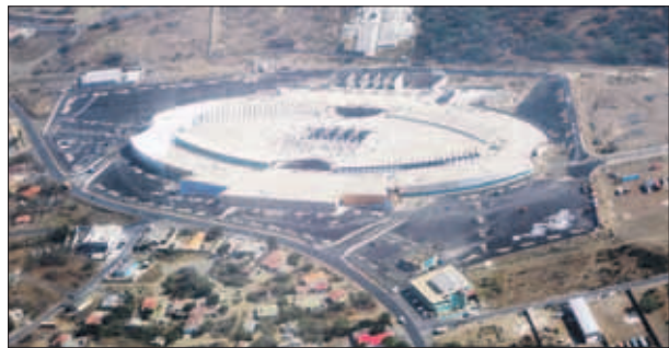
Luchtfoto van megawinkelcomplex Sambil Curaçao in aanbouw in Commercial Park Veeris.
