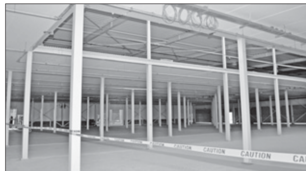
De nieuwe winkel van Building Depot is nu nog een lege ruimte maar moet binnen drie maanden de klanten een nieuwe winkelervaring bieden. FOTO JEU OLIMPIO
