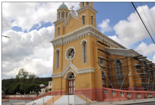
Inmiddels zijn de steigers bij de Sta. Famia-kerk opgesteld en wordt de bouwplaats ingericht.
