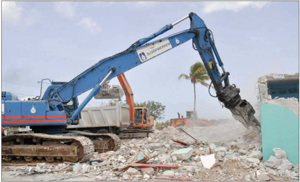
Het winkelcentrum van Colon wordt langzaam afgebrokkeld. Gisteren is een begin gemaakt met het slopen van de zuidvleugel van het complex. De werkzaamheden zullen tot 3 augustus aanhouden. Dus in de schoolvakantie om voor zo min mogelijk overlast te zorgen. Begin september zal begonnen worden met de bouw van Hospital Nobo Otrobanda, zo is de bedoeling. FOTO JEU OLIMPIO
